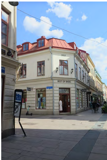
Korsgatan 8, typiskt exempel på sent 1800-tals förändrade bottenvåningar.
