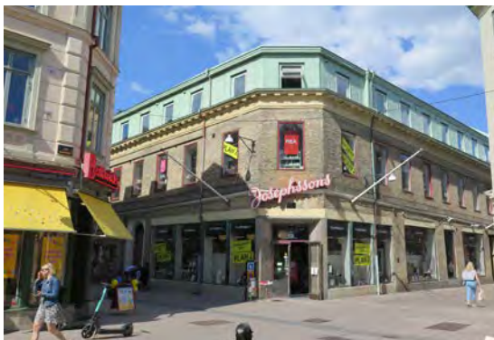
Exempel på på 1900-talspåbyggnad av tidigt 1800-talshus i två våningar. Taket på Korsgatan 12 höjdes i början på 1920-talet efter ritningar av R O Swensson och H Ericsson.
