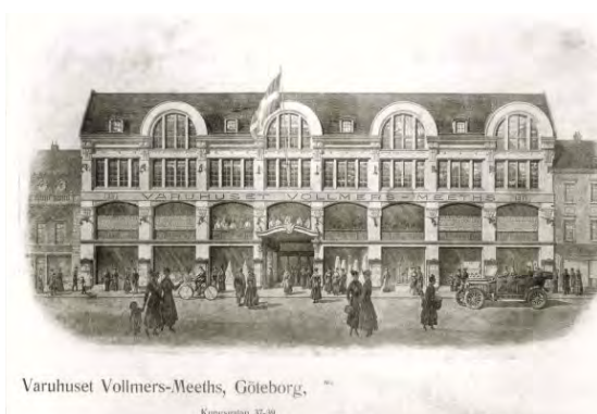
Ett av de varuhus som uppfördes i city vid sekelskiftet 1900 - Meeths på Kungsgatan 37-39, med stora uppglasade ytor.
