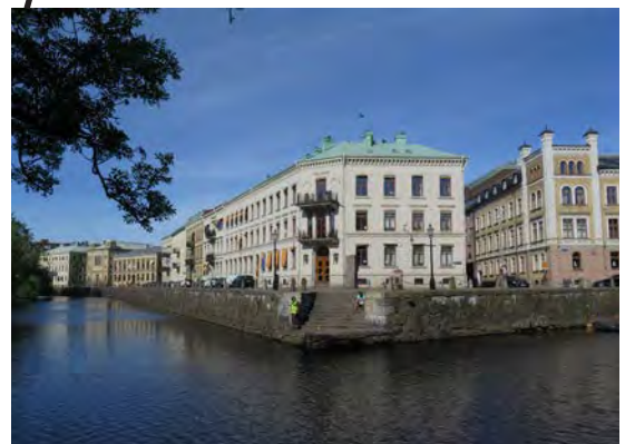
Bebyggelsen utmed Stora Nygatan utgör en välbevarad miljö av sen 1800-talsbebyggelse på det som tidigare var stadens befästningar. Epoken präglar i stort sett hela Vallgravsstråket.
