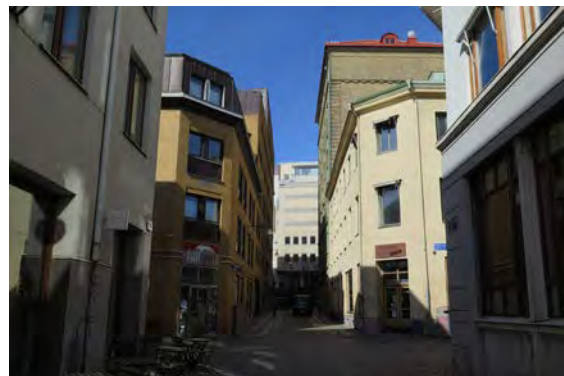
Byggnaden på Magasinsgatan utgör en tydlig referens för intilliggande byggnad, med anpassning i höjd, markerad taklist på samma höjd och avfasat hörn mot korsningen.
