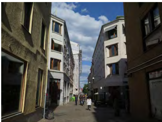
Bebyggelsen på östra sidan om Magasinsgatan är en våning högre, men är anpassade genom avfasade hörn, symmetrisk fönstersättning, markerad takfot och flackt valmat sadeltak.
