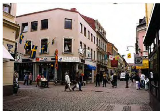
Byggnaden på Korsgatan 17 före ombyggnationen 2003, med den av funktionalismen präglade fasaden från 1938.
