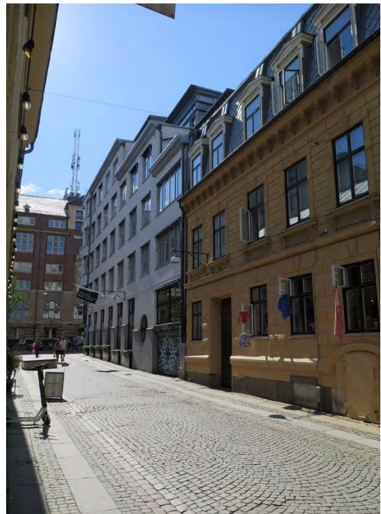
Byggnad utmed Vallgatan från 1992, som tydligt trappas ner för att möta tacknocken på huset på Vallgatan 4.
